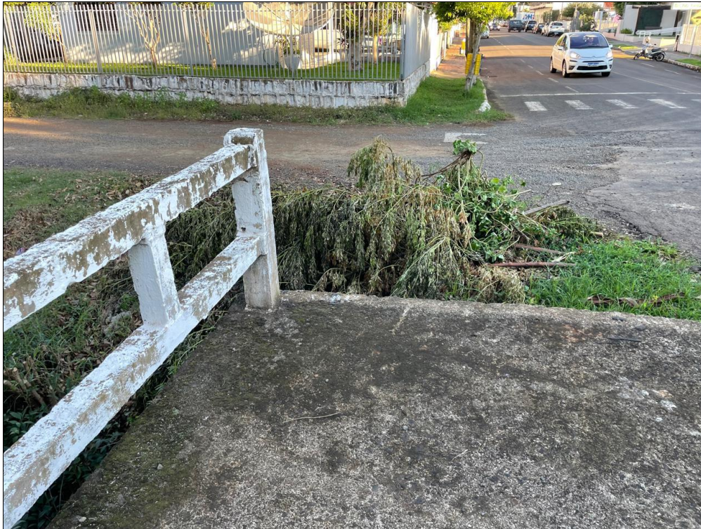
Figura 42 – Disposição irregular de resíduos em Maravilha.
