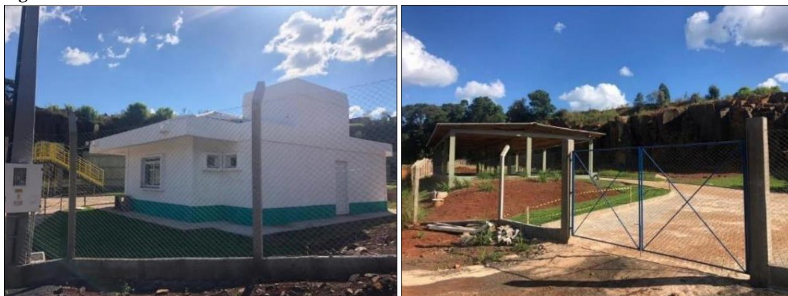
Figura 31 – Estruturas da ETE de Maravilha.
