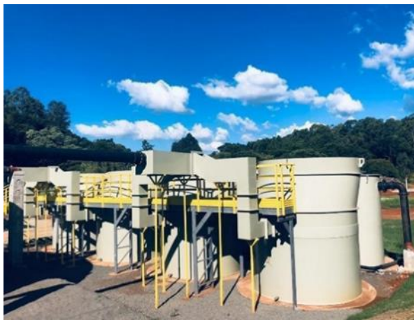
Figura 70 - Reatores UASB.
