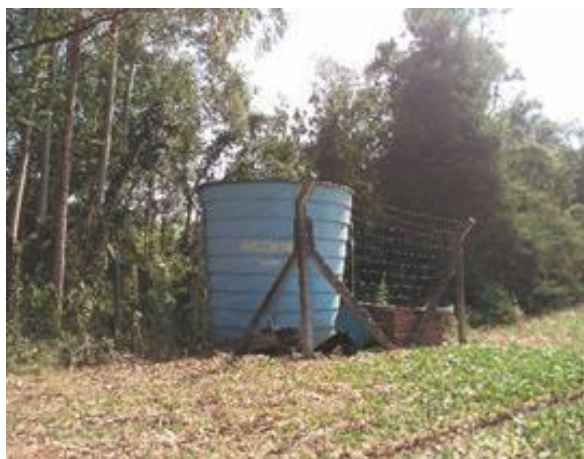
Figura 51 - Local da caixa de distribuição e caixa do aparelho dosador e o galão.
