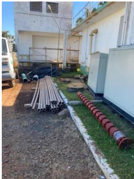
Figura 11 - Acondicionamento de tubos e conexões do SAA.
