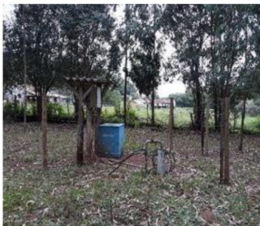
Figura 38 - Local do poço e caixa com aparelhos dosador.
