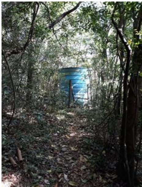
Figura 48 - Local da caixa que abriga o aparelho dosador e o galão de cloro e reservatório da associação.
