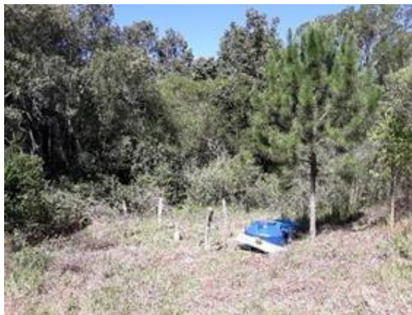
Figura 53 - Local do poço, caixa que abriga o aparelho dosador e o galão de cloro e a caixa de recalque.
