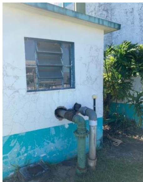
Figura 8 - Entrada da Tubulação na casa de Máquinas.
