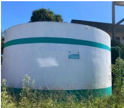
Figura 20 - Antigo reservatório R4.
