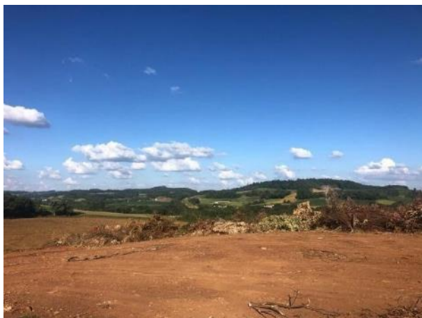
Figura 80 - Vista geral do aterro.
