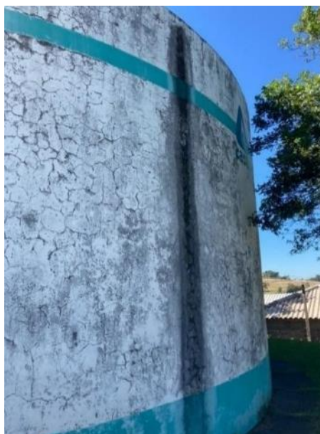
Figura 17 - Reservatório R1 localizado no pátio da ETA.
