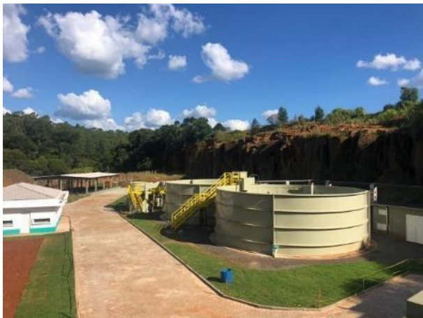
Figura 68 - Vista Geral da ETE de Maravilha.
