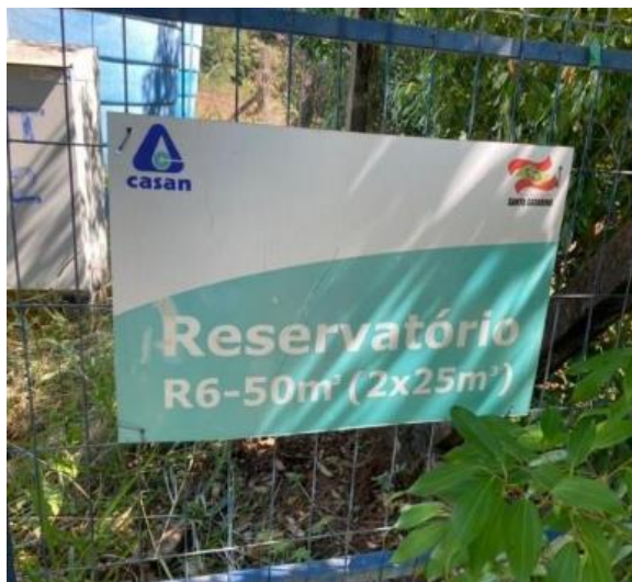
Figura 26 - Identificação Reservatório R6.
