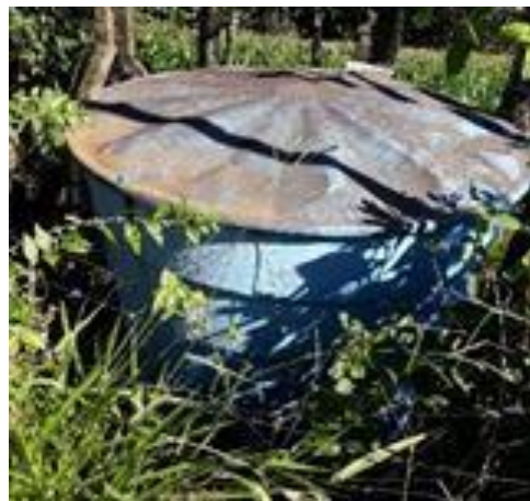
Figura 36 - Caixa de distribuição 2.
