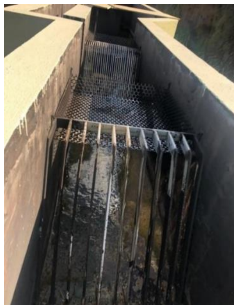
Figura 67 - Grade média seguida de grade fina.
