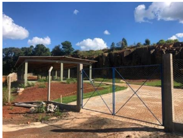
Figura 66 - Estruturas da ETE de Maravilha.
