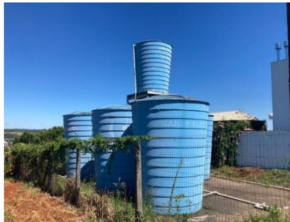
Figura 21 - Antigo reservatório R4.
