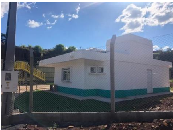
Figura 64 - Estruturas da ETE de Maravilha – SC.
