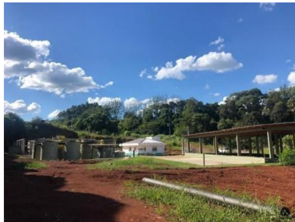
Figura 69 - Vista Geral da ETE de Maravilha.
