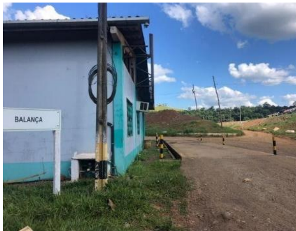
Figura 91 - Balança de controle de entrada.
