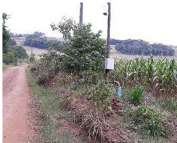
Figura 52 - Local do poço instalado à beira da estrada.
