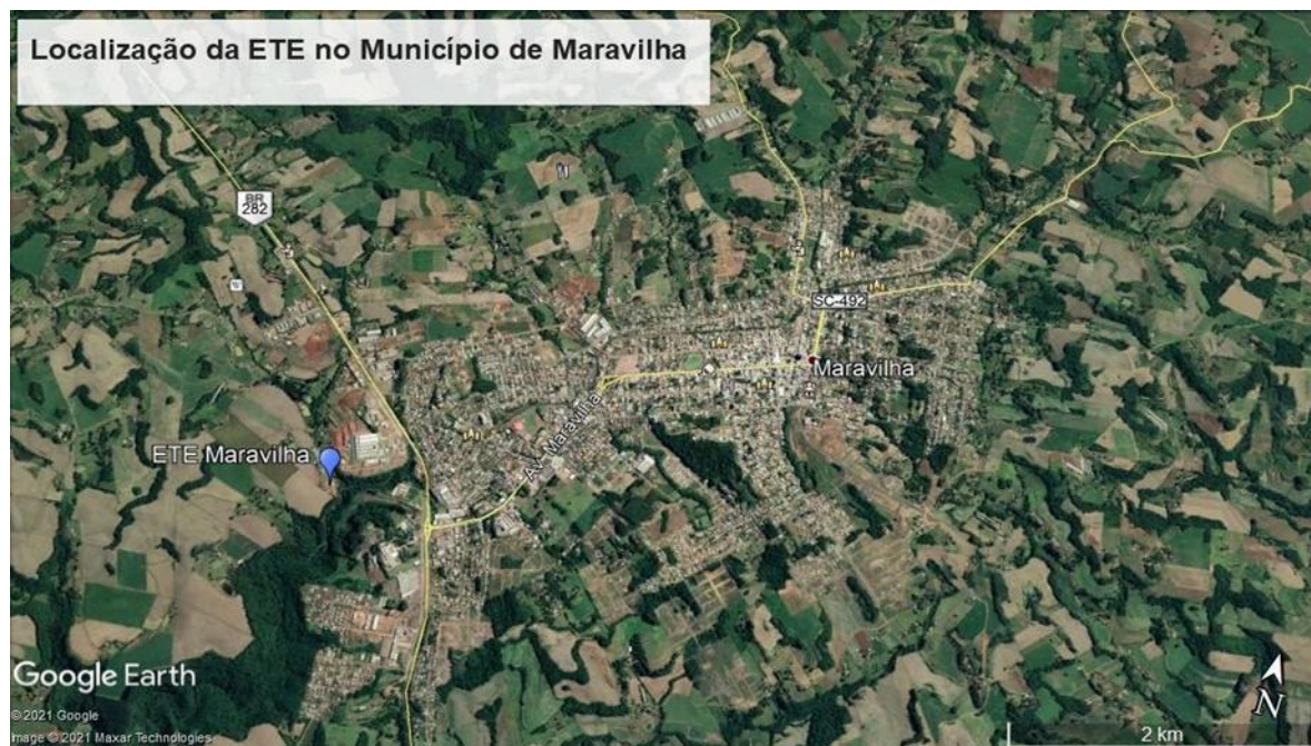
Figura 63 - Localização da ETE em relação à área urbana do município de Maravilha.
