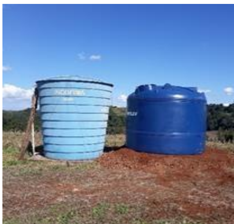
Figura 43 - Reservatórios 1 e 2. O reservatório 2 (da direita) foi recebido em 2021.
