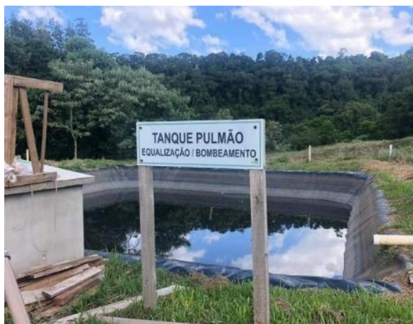
Figura 86 - Tanque Pulmão.
