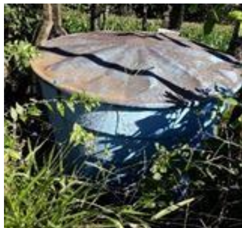
Figura 36 - Caixa de distribuição 2.
