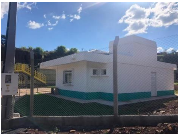
Figura 64 - Estruturas da ETE de Maravilha – SC.
