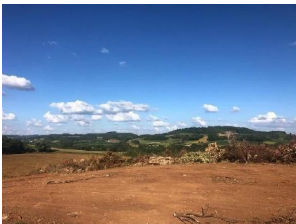
Figura 80 - Vista geral do aterro.
