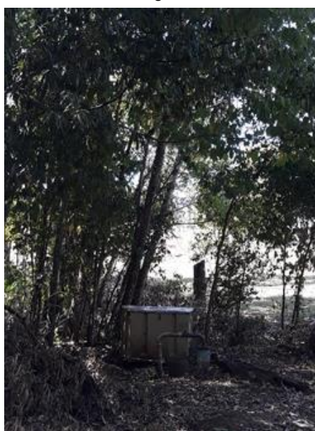
Figura 32 - Local do poço e da caixa que abriga o aparelho dosador e o galão de cloro.
