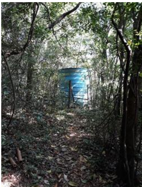
Figura 48 - Local da caixa que abriga o aparelho dosador e o galão de cloro e reservatório da associação.
