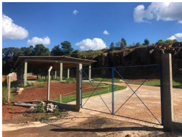
Figura 66 - Estruturas da ETE de Maravilha.
