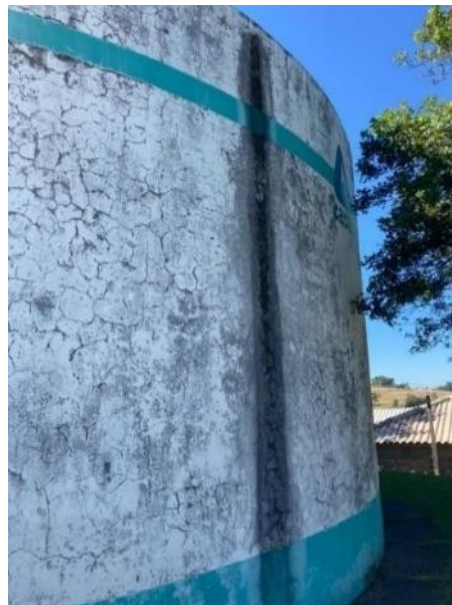
Figura 17 - Reservatório R1 localizado no pátio da ETA.
