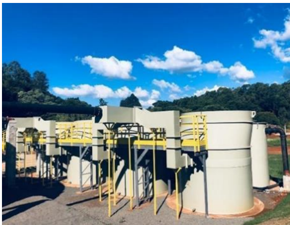
Figura 70 - Reatores UASB.
