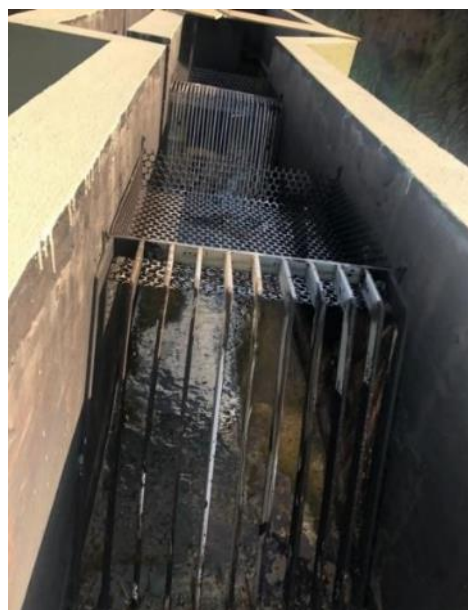
Figura 67 - Grade média seguida de grade fina.
