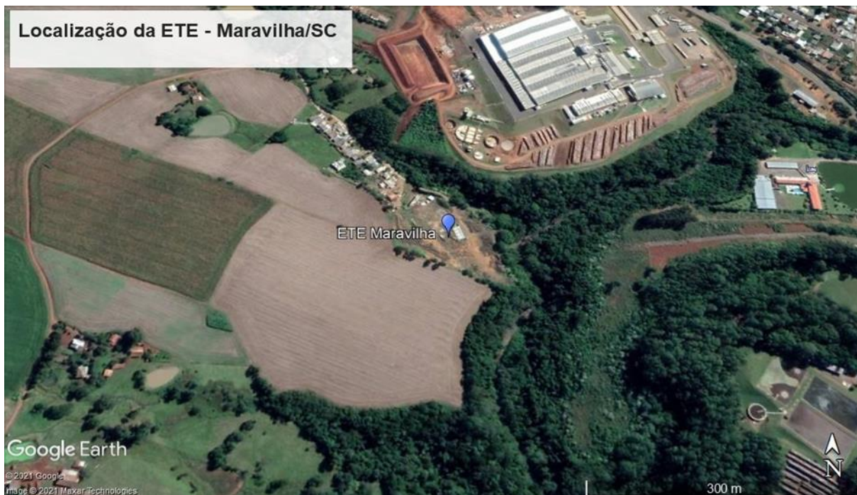
Figura 62 - Localização da ETE no município de Maravilha.
