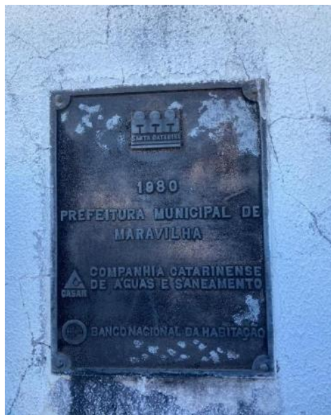
Figura 3 - Placa de identificação da ETA.
