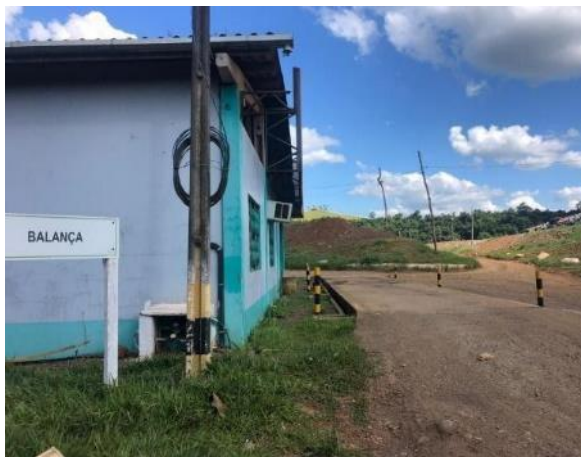
Figura 91 - Balança de controle de entrada.
