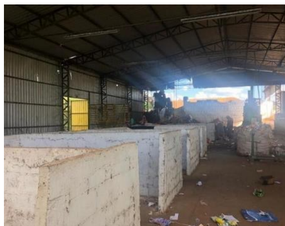
Figura 94 - Baias de segregação de materiais recicláveis.
