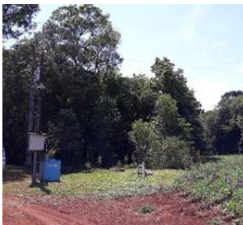
Figura 42 - Local do poço e caixa que abriga o aparelho dosador e o galão de cloro.
