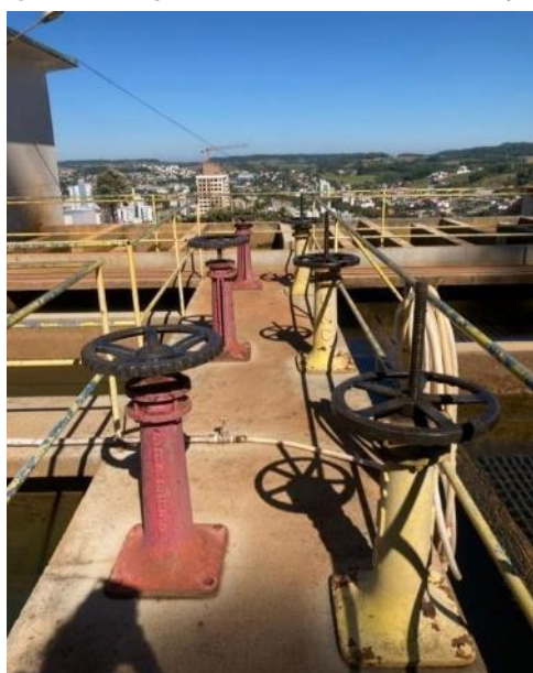
Figura 9 - Registros do sistema dedecantação.
