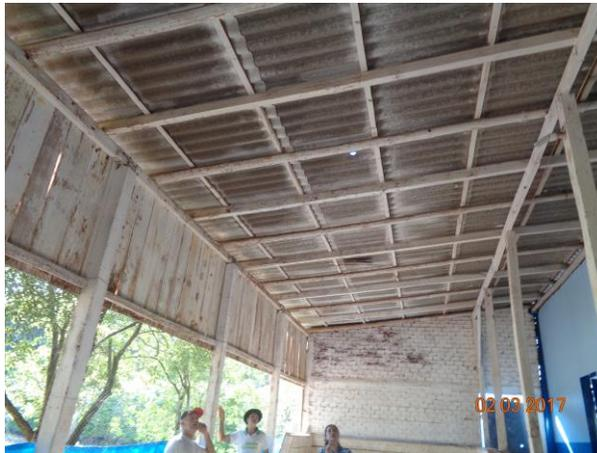
Imagem 02 – parte interna da cancha (telhamento em fibrocimento)
